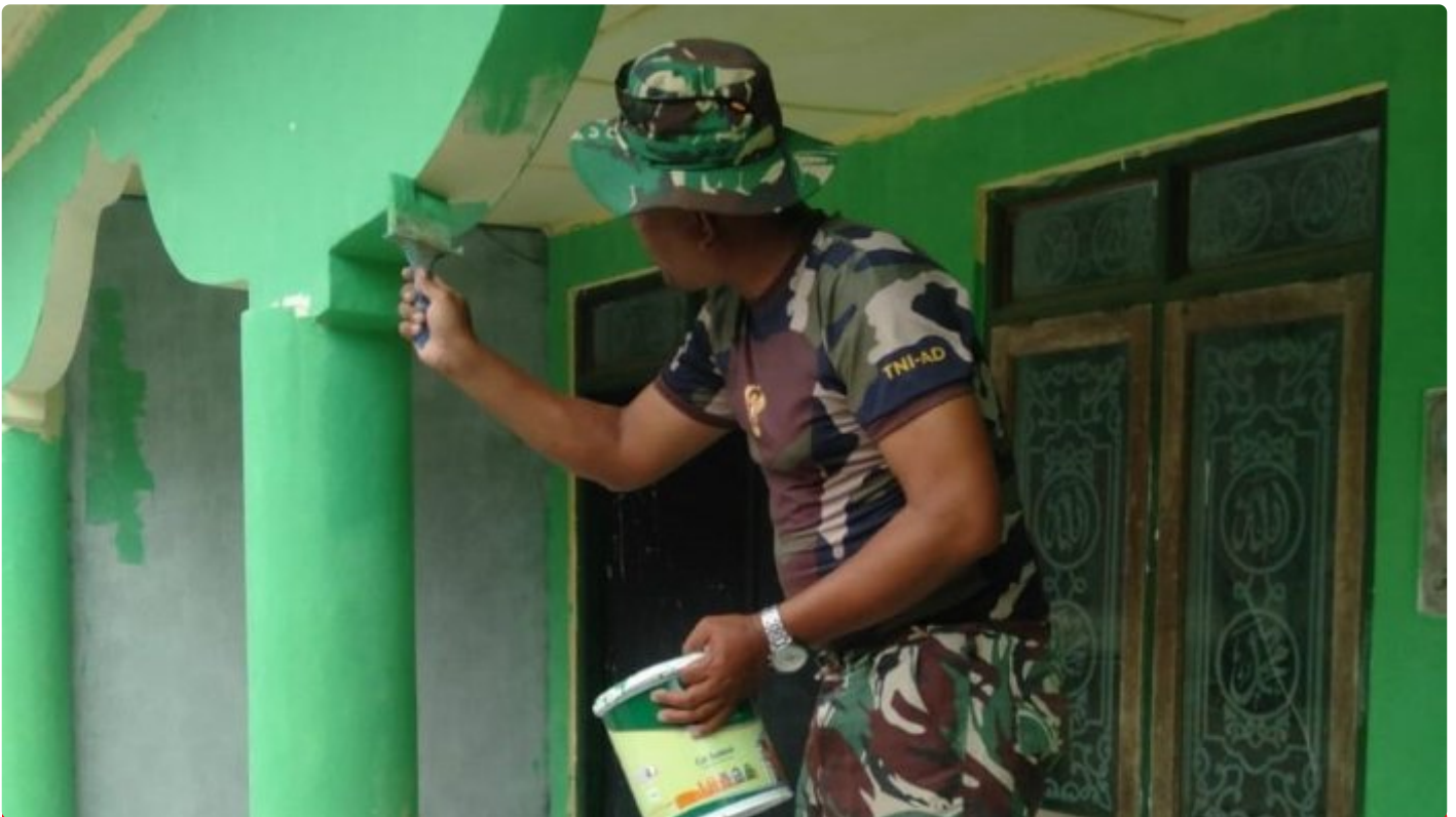
Satgas TMMD Lakukan pengecatan Finishing Rehab Mushola Di Desa Cangkring
